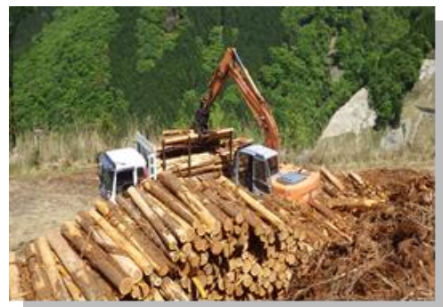
木材積載状況
