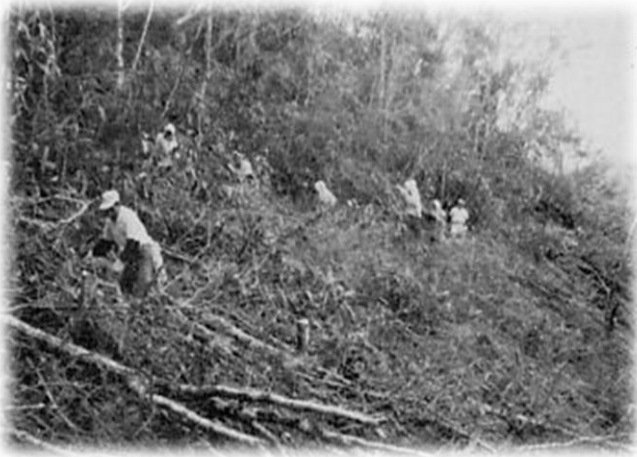
標高1,000m、平均勾配35° 天然林に挑む地拵え作業
