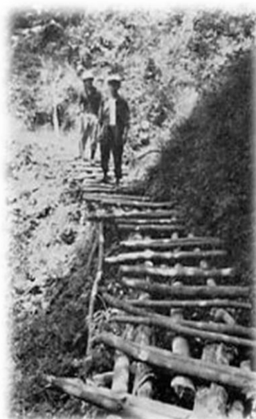
急傾斜地歩道(片栈橋)
